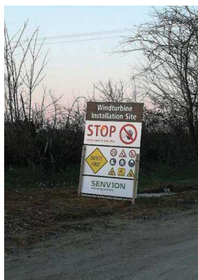
Figure 210 : Exemple de signalisation en entrée de chantier d'un parc éolien (Crédit photo : NCA Environnement, 2018)
